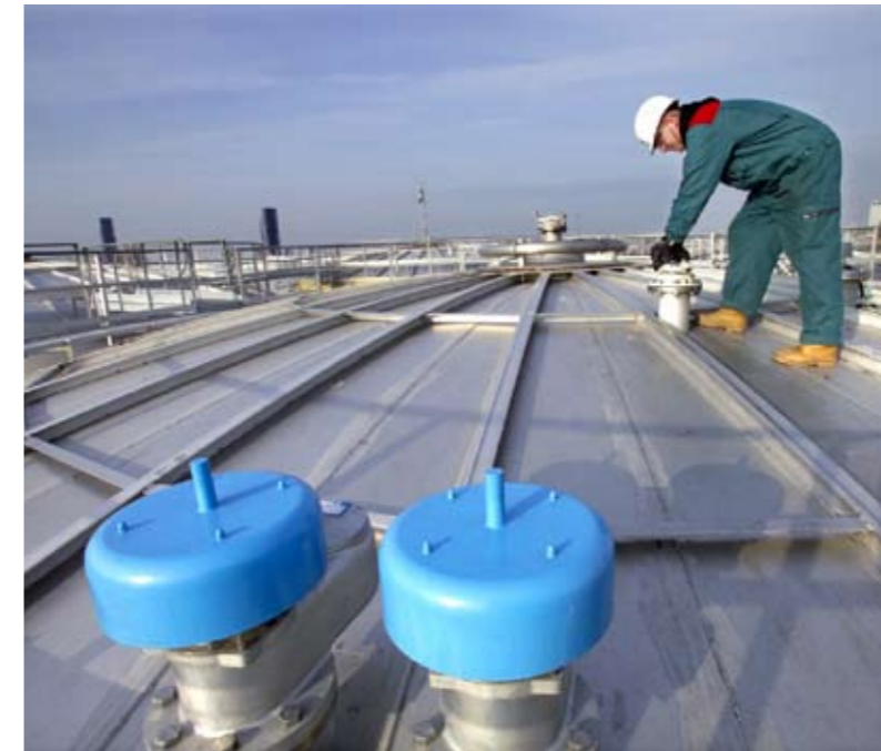
Aufs Dach gestiegen: Zur Sicherheit im Ölhafen gehört die Tanklager-Kontrolle auf dem Dach
